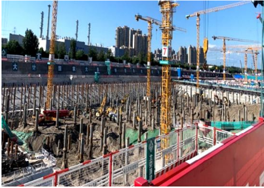
图 3 基坑施工现状
