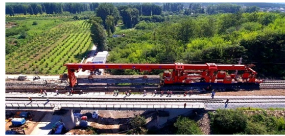
图 8 破损梁整体快速更换
